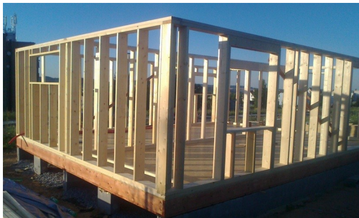
Sloupková konstrukce dřevostavby, foto František Němec
