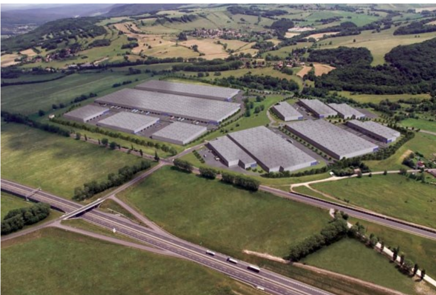
Jeden ze skrytých důsledků dovozu zboží - výstavba logistických parků na zelené louce, foto - zdroj: www.asb-portal.cz
