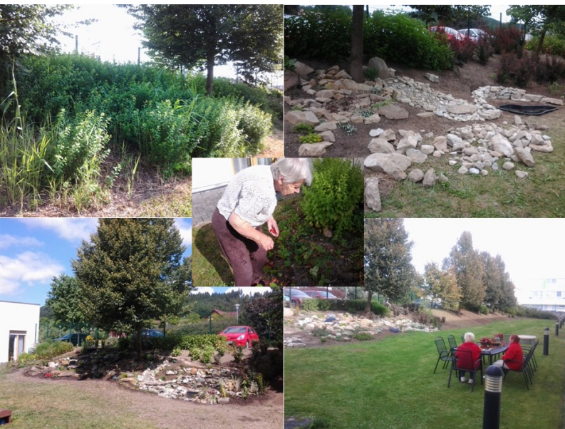
Budování relaxační zahrady, rozpracovaný terén čekající na dokončení v roce 2015, foto Andrea Chocholetá
