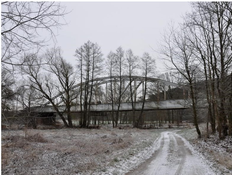
Železniční most u Dolního Poříčí, foto -vh-
