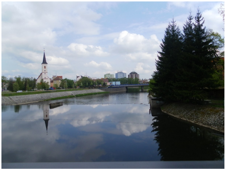
Pětikolský jez na Otavě - napravo místo s dřevinami, které by mělo ustoupit projektu MVE, foto -jj-
