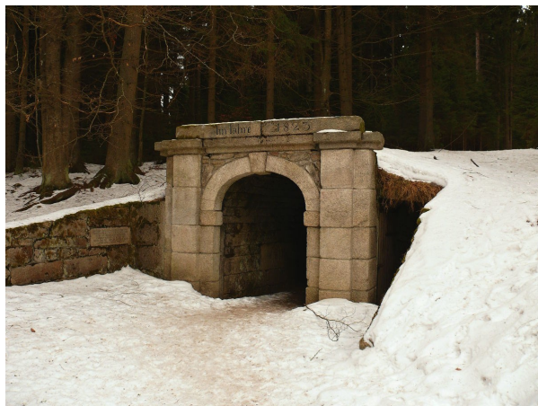
Portál podzemního tunelu Schwarzenberského kanálu, foto Jakub Hromas
