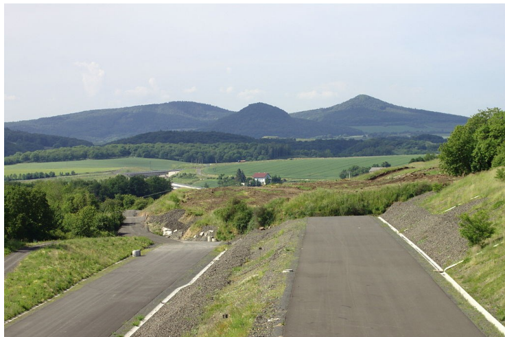
Zával úseku dálnice D8 u Prackovic nad Labem, foto Aktron / Wikimedia Commons
