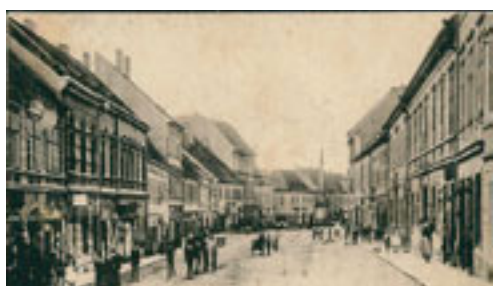
Pohlednice I. rep. sokolově před domem č.p. 142
