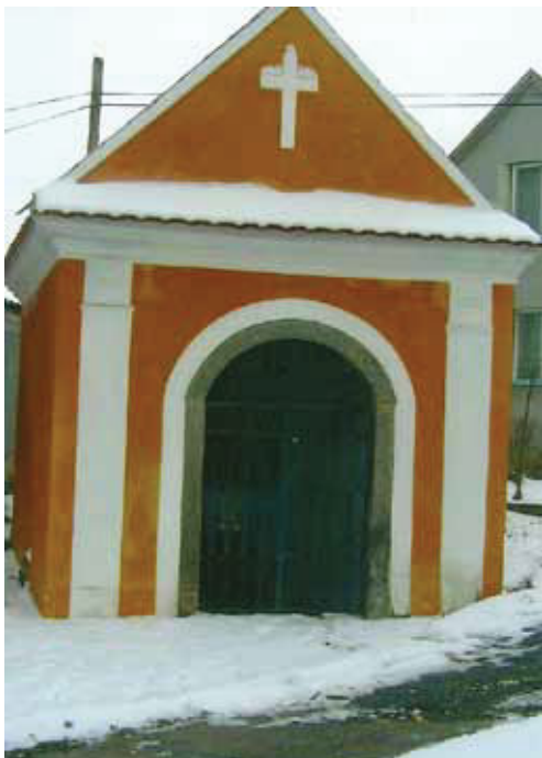
Kaplička sv. J. Nepomuckého po opravě r. 2014
