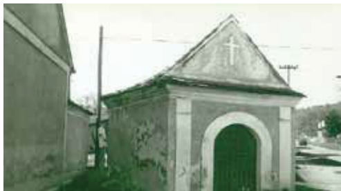
Kaplička sv. J. Nepomuckého před opravou
