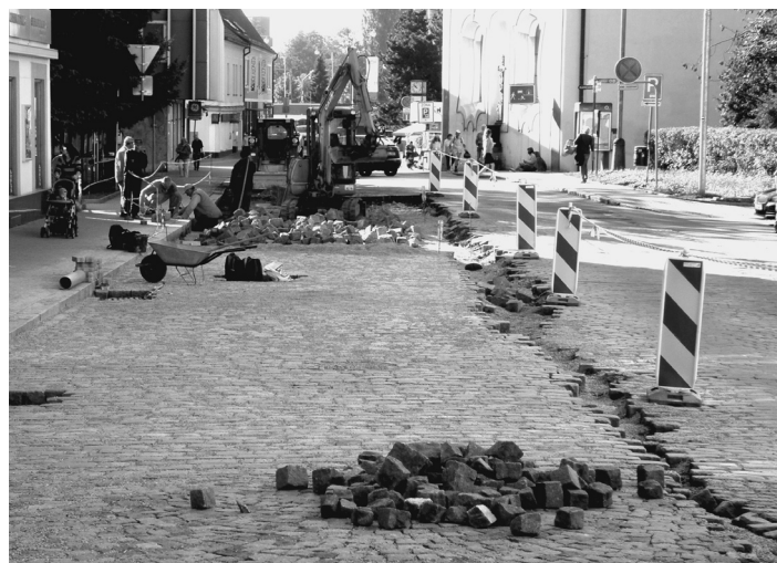
Oprava ulice U Sv. Markéty.
