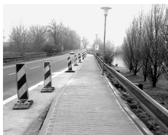
Pro zvýšení bezpečnosti občanů Střele byl vybudován chodník za 1 milion korun.
