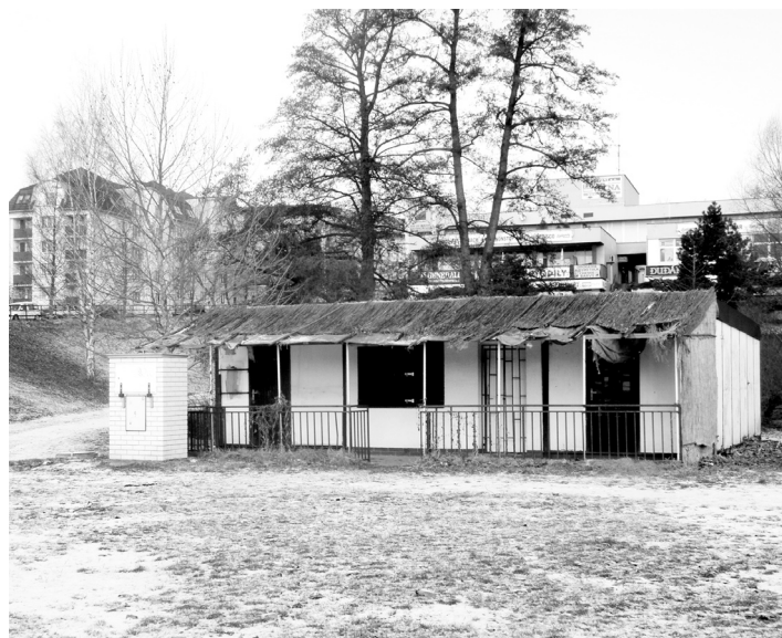
Bývalé veřejné WC čeká demolicí.
