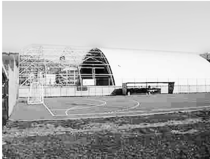
Venkovní hřiště s umělým povrchem je hotové, házenkářská hala ve výstavbě. Foto: Archiv oddílu házené
