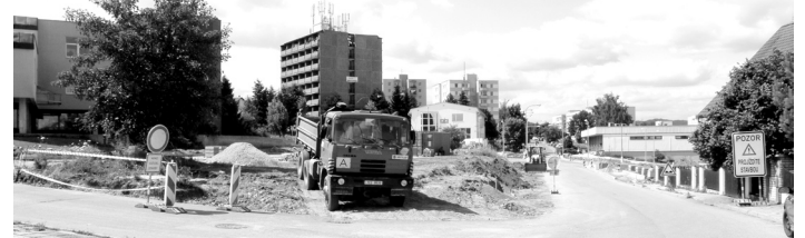
Stavební úpravy v okolí ZŠ Povážská.
