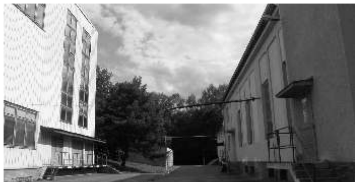
Pracejovickou vodárnu čeká rekonstrukce. Objekt vlevo bude zbourán. Foto: I. Malotová, archiv MěÚ
