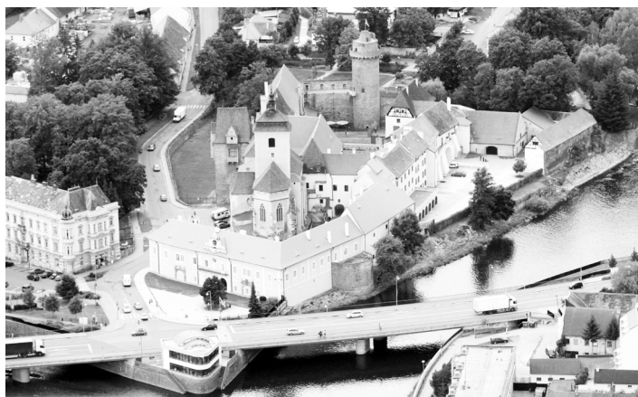
Za posledních deset let bylo do oprav strakonického hradu investováno 195 milionů korun. Foto: Archiv MěÚ
