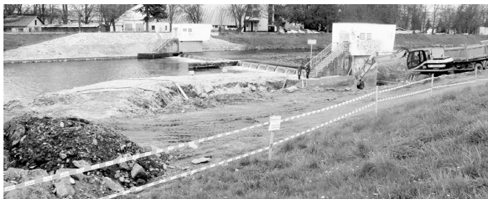
Jez Na Křemelce se díky propusti stane bezpečnějším. Foto: Archiv MěÚ
