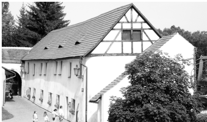
Objekt dětského oddělení Šmidingerovy knihovny bude kompletně opraven. Foto: Archiv MěÚ
