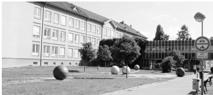
Budova Základní školy Dukelská ještě před stavebními úpravami.
