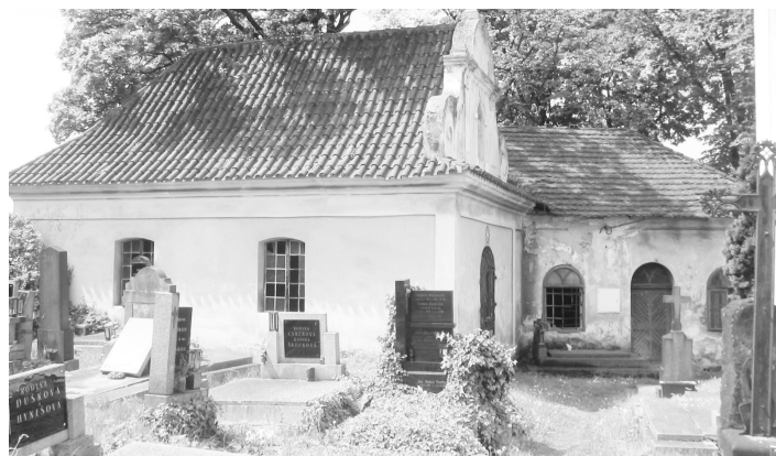
Zchátralé památkově chráněné objekty na hřbitově budou opraveny, nezapomene se ani na hřbitovní zeď.
