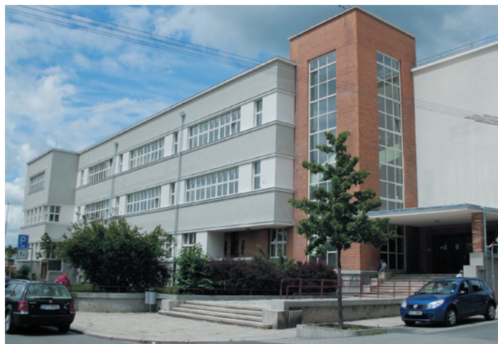
Budova Základní školy Čelakovského v Chelčického ulici září novotou.
