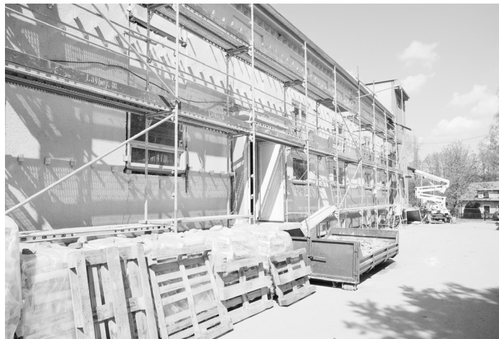
Na snímku objekt hlavní budovy, který se nachází ve stavu těsně před zateplením a novou fasádou.
