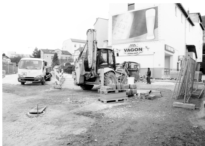
V prosinci bylo otevřeno po dvou měsících parkoviště v Podskalské ulici, kde probíhala revitalizace. Vznikla zde parkovací plocha z velkoformátové betonové dlažby. Snímek zachycuje pokládku dlažby. Foto: Archiv MěÚ
