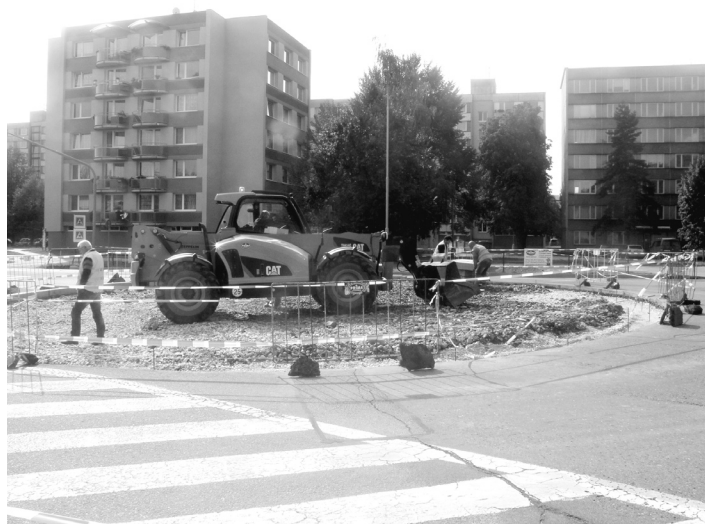
V měsíci září byla vybudována kruhová křižovatka v ulici Ellerově.
