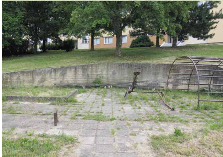
Dětské hřiště po opravě a stav před opravou
