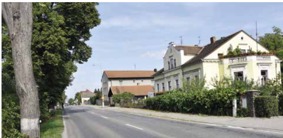
Komunikace Volyňská už volá po celkové rekonstrukci
