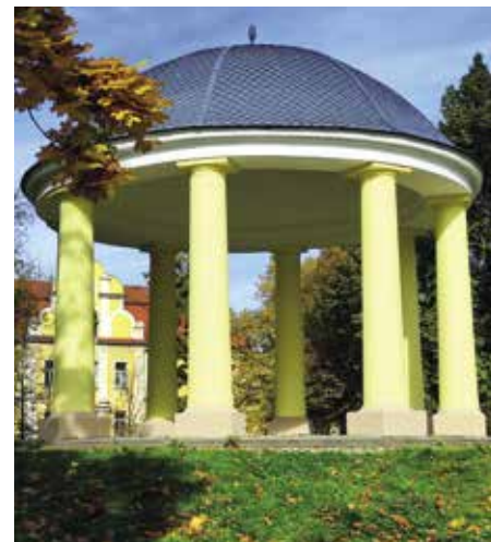
Altán ve své kráse po opravě v roce 2021
