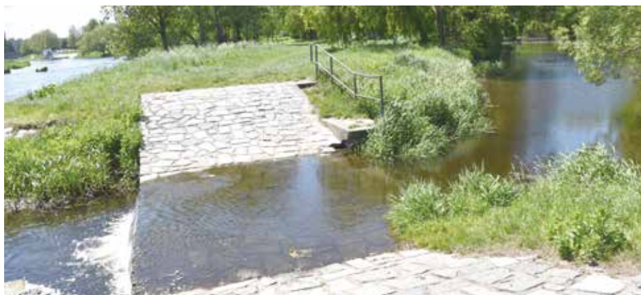
Takto vypadá brod na začátku rekonstrukce
