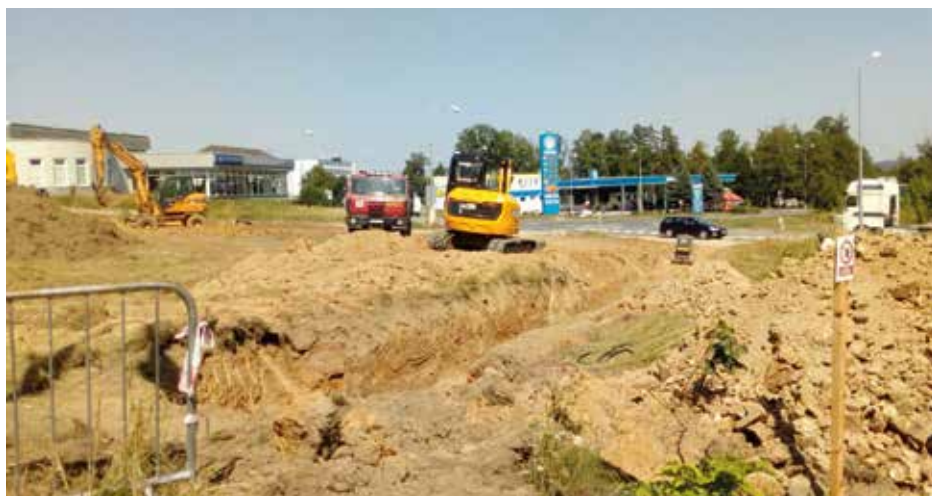
Stavební práce v ulici Písecká
