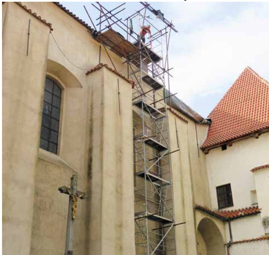
Oprava střechy kostela sv. Prokopa
