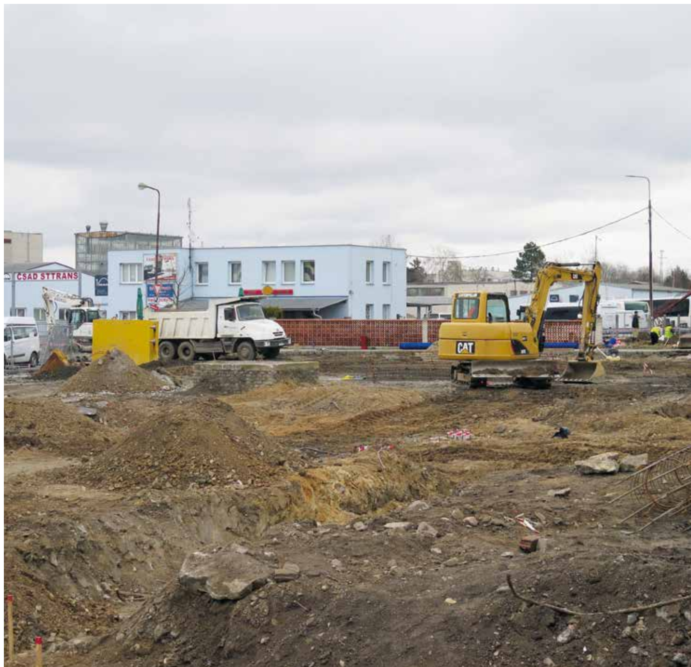
Výstavba nového autobusového terminálu je v plném proudu, kvůli ní bude až do konce listopadu uzavřena ulice Nádražní. Moderní terminál by měl podle předpokladů cestujícím sloužit v závěru roku.
