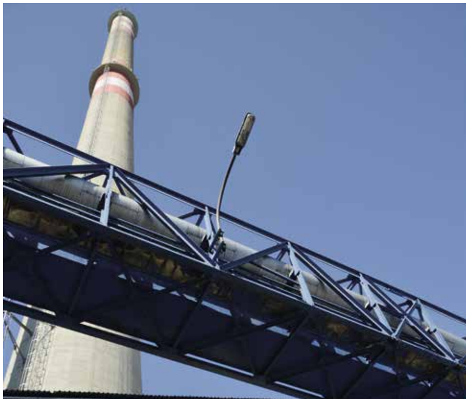
Il. foto: teplárna
