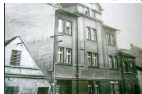
Č.p. 169 dřv pekárna J. a M. Maříkových,
