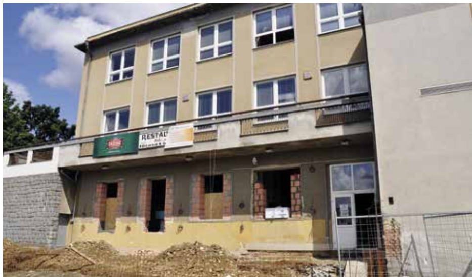
První etapa rekonstrukce domu kultury by měla být hotova v únoru 2020
